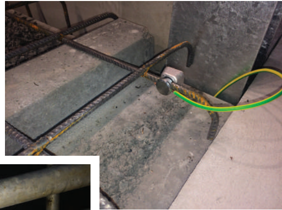
Mise à la terre avant beton
