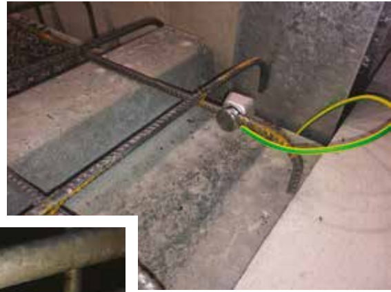
Mise à la terre avant beton
